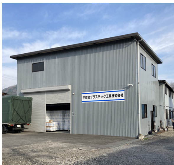
平成29年 工場増設
